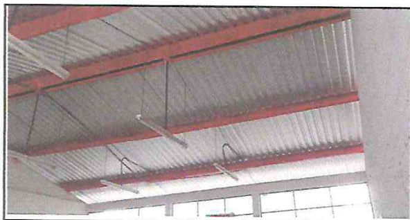
Foto 5: Se observa el cambio de pintura de en costanera y la instalacion de láminas. Módulo 3
