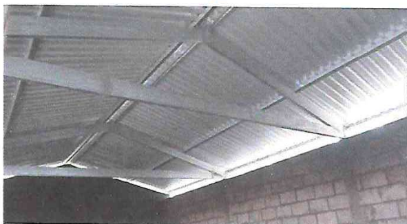
Foto 4: Se observa Modulo. 2. El cambio de estructura portante.
